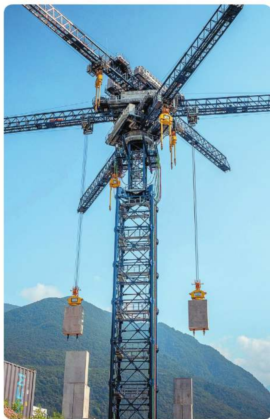
Ryc. 27.2. EV1 CDU – specjalna konstrukcja w Arbedo-Castione w Szwajcarii, w której magazynuje się energię grawitacji wielkich betonowych bloków.
