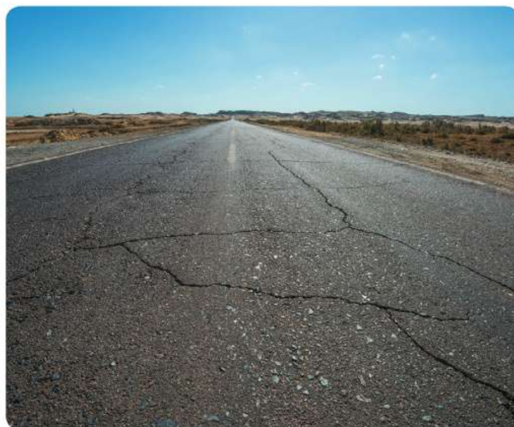
Ryc. 34.4. Skutki powiększania się objętości zamarzającej wody
