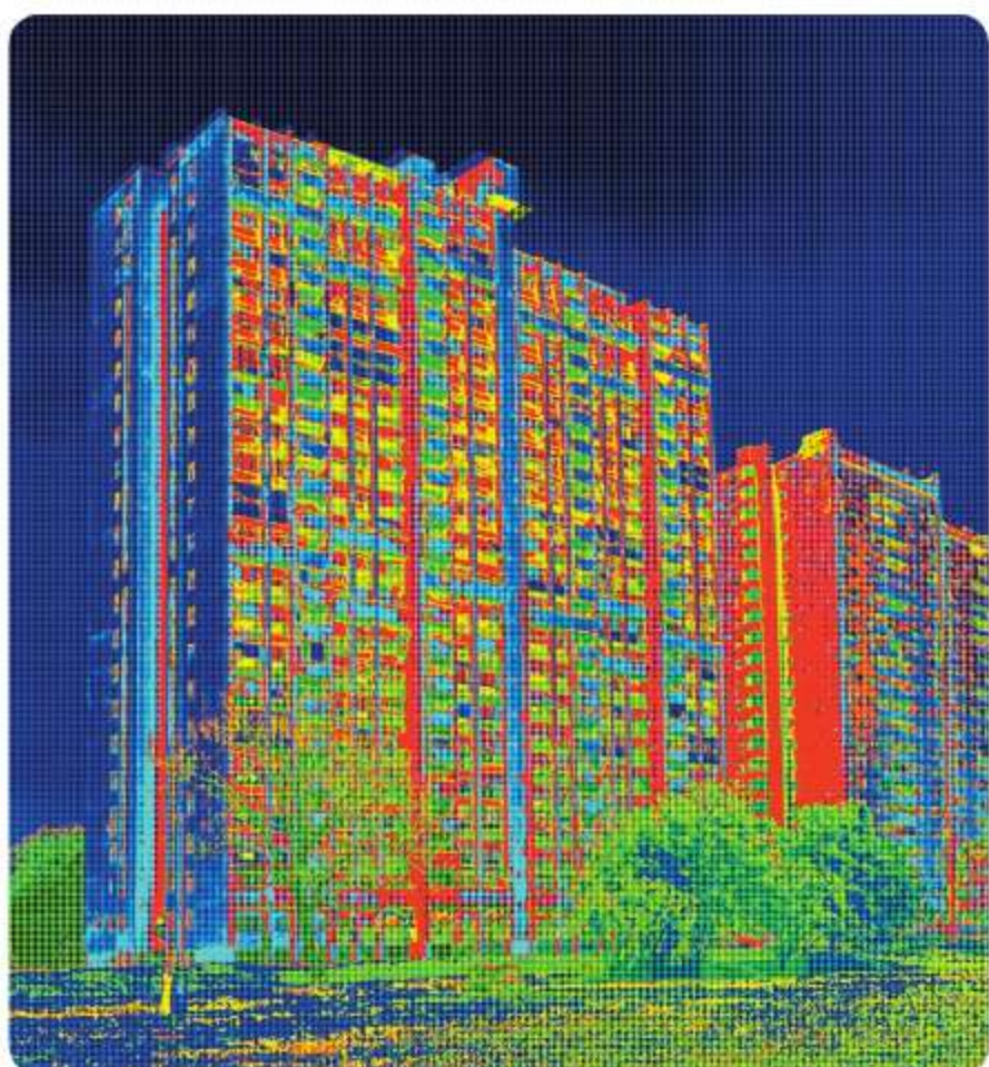
Ryc. 36.2. Obraz z kamery termowizyjnej budynków z lepszą (budynek po lewej) i gorszą (budynek po prawej) izolacją ścian szczytowych
