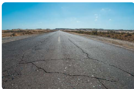
Rys. 33.6. Skutki powiększania się objętości zamarzającej wody
