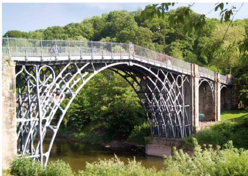
Most żelazny wzniesiony z inicjatywy Johna Wilkinsona w 1779 r. do dziś łączy oba brzegi rzeki Severn w zachodniej Anglii. Konstrukcję wykonano, wzorując się na rozwiązaniach stosowanych w budowach drewnianych.
