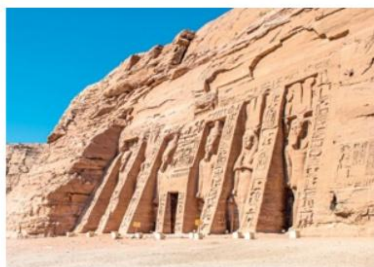
Zespół świątynny w Abu Simbel, Egipt, XIII w. p.n.e. Kamień jest tu zarówno elementem konstrukcyjnym, jak i dekoracyjnym (kamienne posągi).
