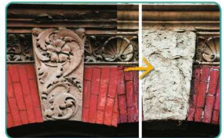
Niszczenie budynków i konstrukcji stalowych
