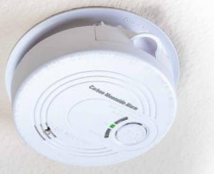
Fot. 72. W pomieszczeniach ogrzewanych piecami węglowymi i gazowymi warto instalować czujniki sygnalizujące obecność tlenku węgla(II).
