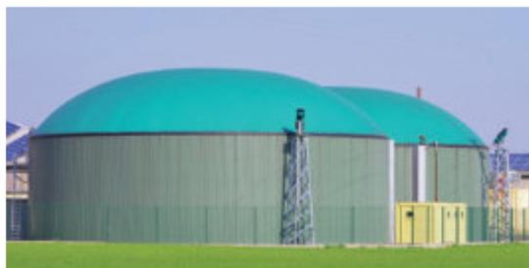
Komory fermentacyjne na terenie biogazowni
