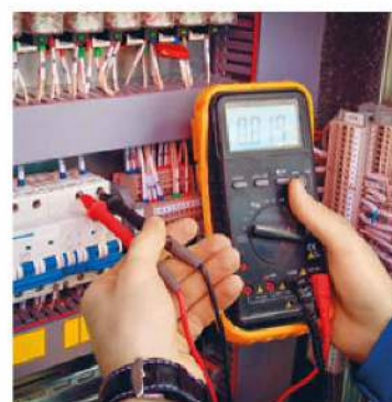
▲ Z miernika włączonego jako woltomierz napięcia przemiennego (AC) odczytujemy napięcie skuteczne
