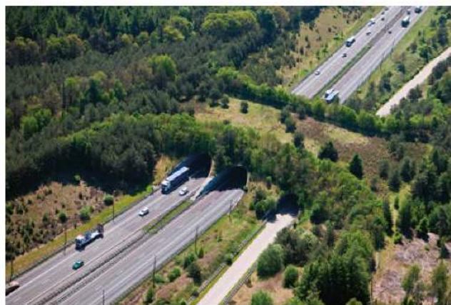
Budowa przejść dla zwierząt nad autostradami i drogami ekspresowymi pozwala uniknąć blokowania naturalnych korytarzy ekologicznych. W Polsce jest wymuszona prawem.
