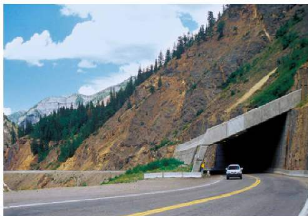
W miejscach występowania ruchów masowych, np. nad drogami w Alpach, buduje się specjalne osłony.
