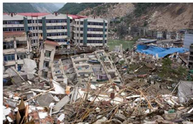
W chińskim mieście Beichuan w 2008 r. w wyniku trzęsienia ziemi o magnitudzie 8 uległo zniszczeniu ok. 80% budynków.
