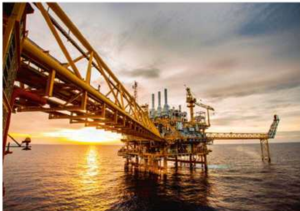
Rys. 25. Platforma wiertnicza budowana w morzu.
