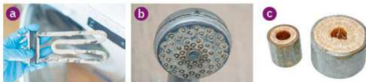
Rys. 4.1. Negatywne skutki twardości przemijającej wody: a) element grzejny pralki pokryty kamieniem kotłowym; b) głowica prysznica pokryta osadem węglanu wapnia (magnezu); c) przekrój rury wodociągowej z widocznymi złożami węglanu wapnia (magnezu).
