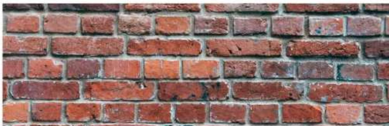
Rys. 2.7. Fragment starego muru, w którym cegły połączone są ze sobą zaprawą wapienną.
