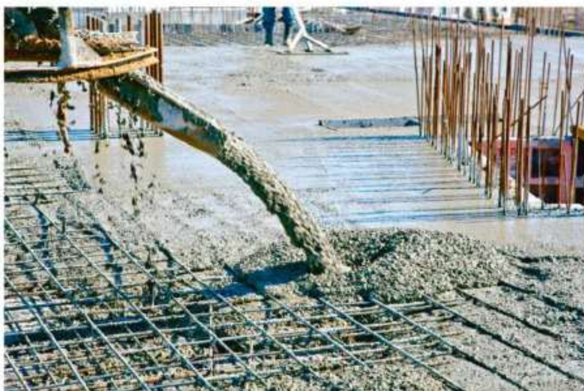
Rysunek 4. Beton na budowie.
