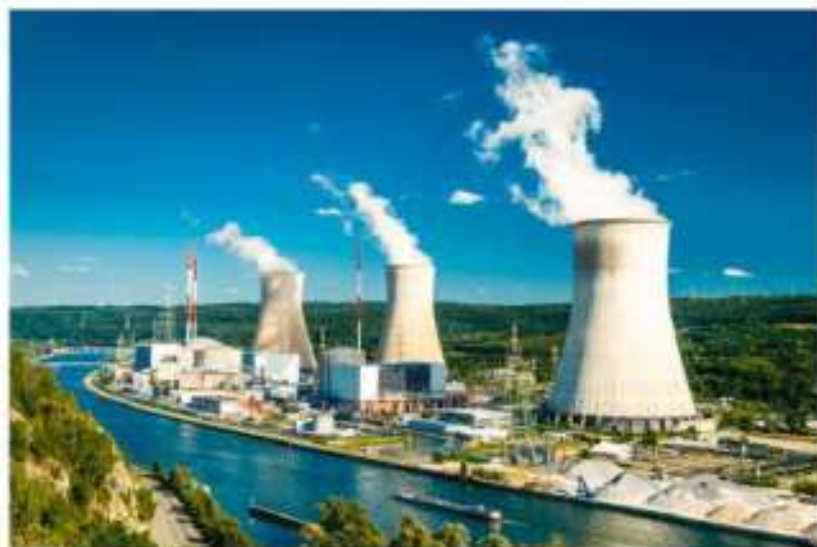
Rys. 3.5. W elektrowniach jądrowych uzyskaną energię powstającą w wyniku kontrolowanego rozszczepienia jąder zużywa się do napędzania turbin parowych uruchamiających generatory prądu elektrycznego.
