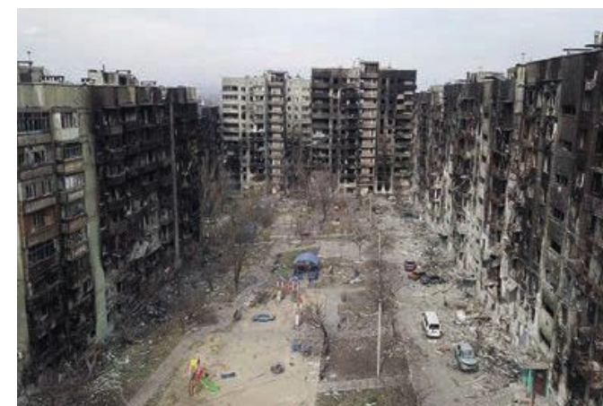
Wskutek rosyjskiej inwazji niemal całkowitemu zniszczeniu uległo wiele ukraińskich miast, m.in. Mariupol (fot.), Bachmut i Siewierodoneck.
