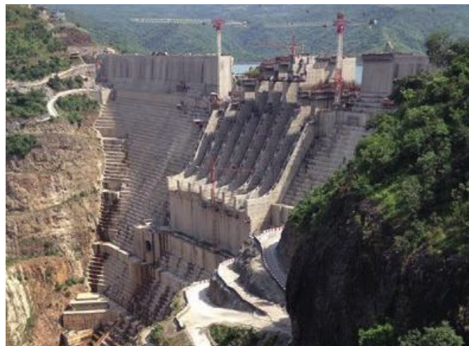
Przykładem budowy hydrotechnicznej, która może wywołać katastrofalne zmiany w środowisku przyrodniczym, jest tama na rzece Omo w Etiopii.
