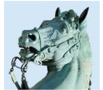
Fot. 55. Patyna to zielony nalot powstający w wyniku korozji elektrochemicznej.
