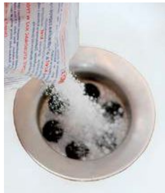
Fot. 40. Wodorotlenek sodu skutecznie usuwa tłuste zanieczyszczenia zgromadzone w rurach.
