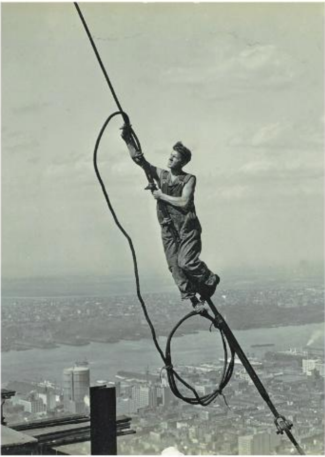
Lewis Hine [czyt. luis hajn] w 1930 r. fotografował robotników pracujących przy budowie Empire State Building [czyt. empajer stejt bilding] – najwyższego budynku świata aż do roku 1973. Fotograf codziennej ciężkiej pracy nadał wymiar mitu, a robotnika na wysokości porównał do Ikaru spełniającego swoje marzenie.
