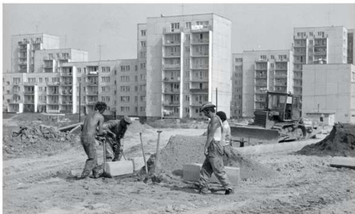
Budowa osiedla w latach siedemdziesiątych.
