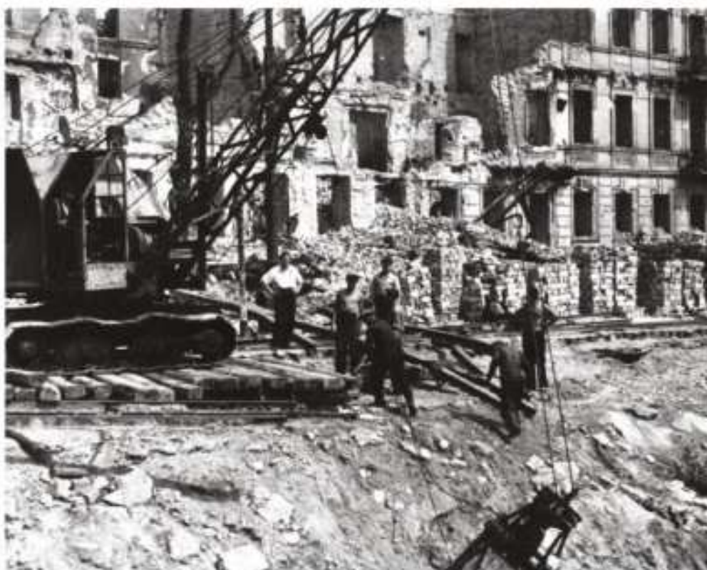
Aleje Jerozolimskie w Warszawie – wyburzenia zniszczonych budynków i budowa tunelu, 1946 r.
