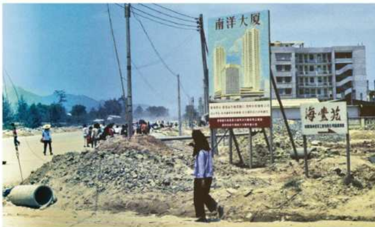
Plac budowy w specjalnej strefie ekonomicznej w Shenzhen, 1982 r.
