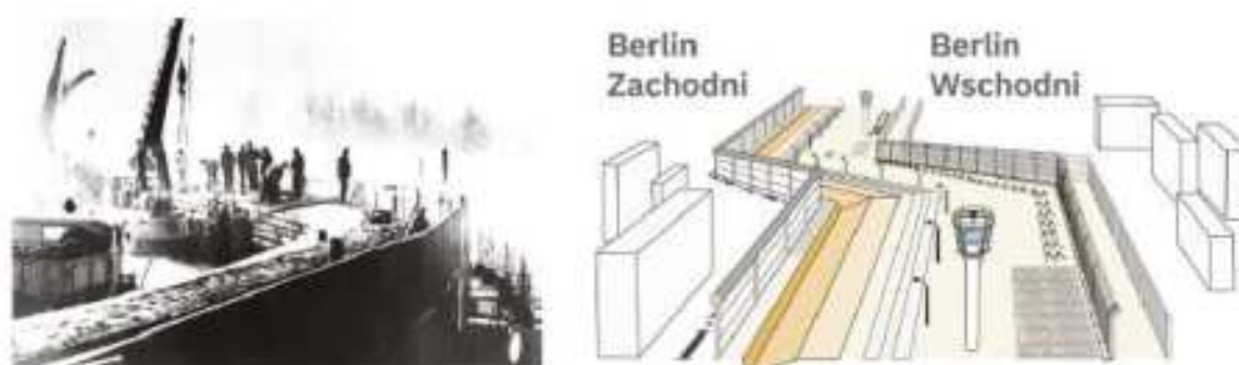
Prace przy budowie muru berlińskiego w listopadzie 1961 r. i schemat przedstawiający strukturę tworzącego go systemu umocnień
