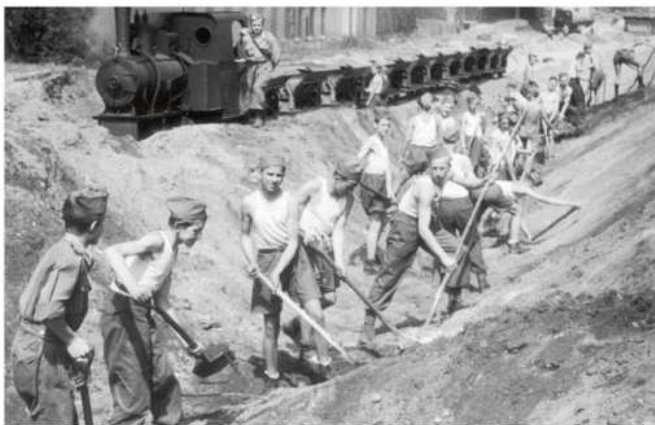
Junacy ze „Służby Polsce” podczas prac przy Dworcu Wileńskim w Warszawie w ramach budowy Trasy W-Z, 1948 r.
