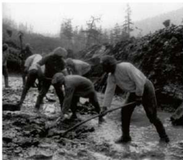
Kołyma – budowa drogi przez więźniów GUŁagu
