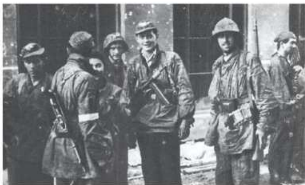
Żołnierze batalionu „Zośka” po przejściu kanałami do Śródmieścia, 2 września 1944 r.
