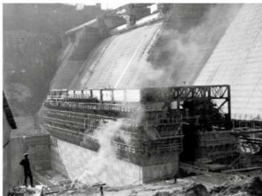
Zapora Norrisa w Tennessee (czytaj: tenesi) w USA w trakcie budowy
