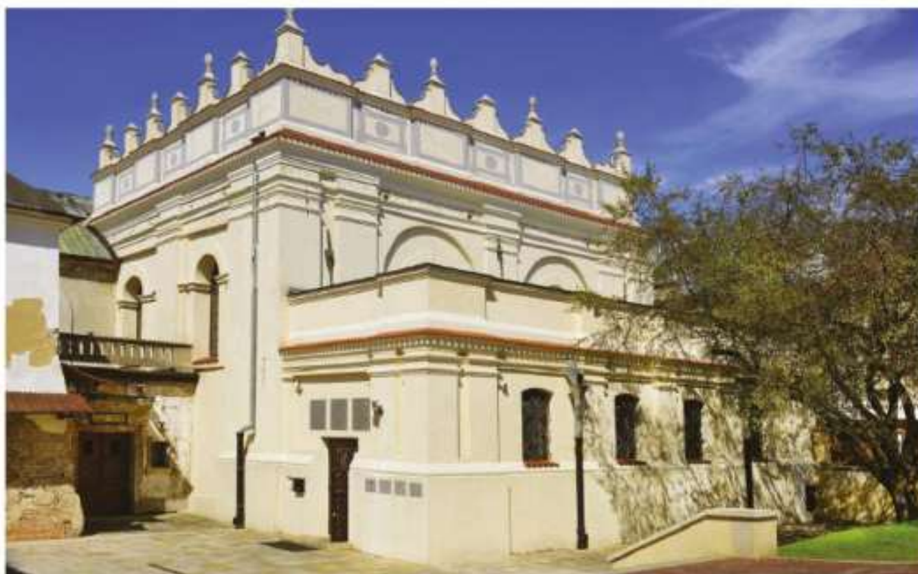
Późnorennesansowa synagoga w Zamościu, początek XVII w.
