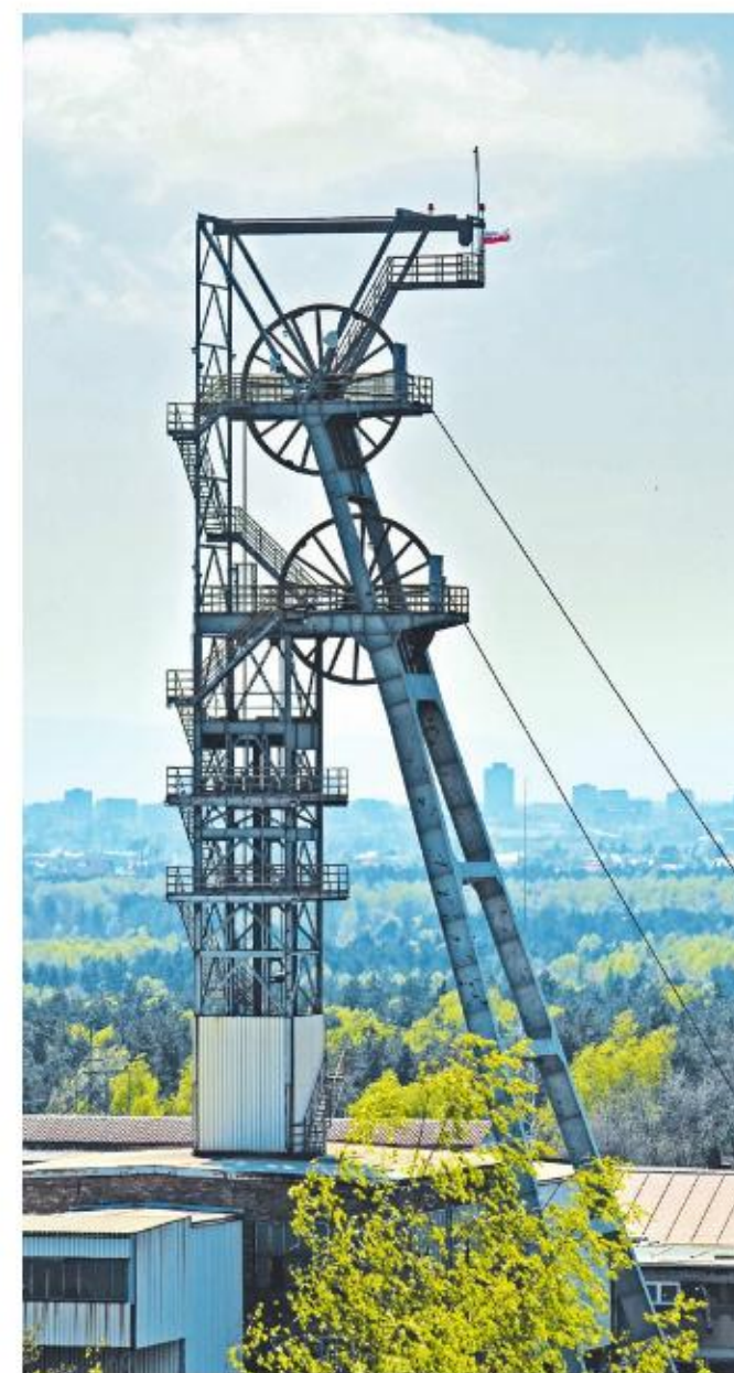
2.47 Nadziemna konstrukcja windy górniczej
