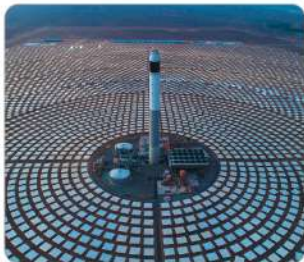
Elektrownia słoneczna Noor Ouarzazate
