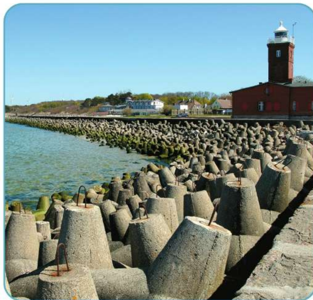
Betonowe umocnienia falochronu portu w Darłówku
