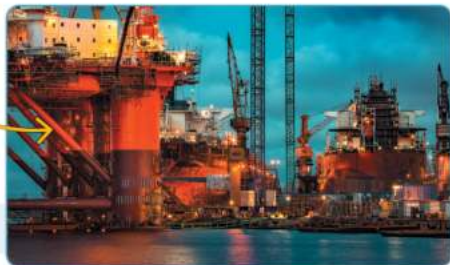
Platforma wiertnicza remontowana w gdańskiej stoczni
