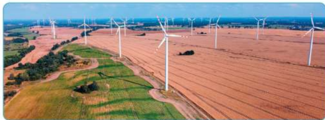
Elektrownia wiatrowa w Póbleciu w woj. pomorskim
