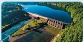
Elektrownia wodna na Dunajcu
