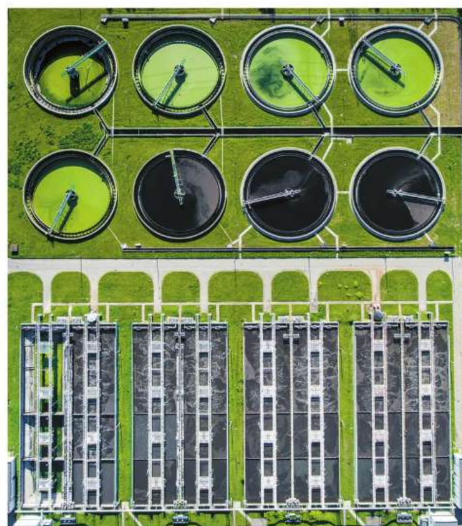
▲ Polska oczyszczalnia ścieków z lotu ptaka
