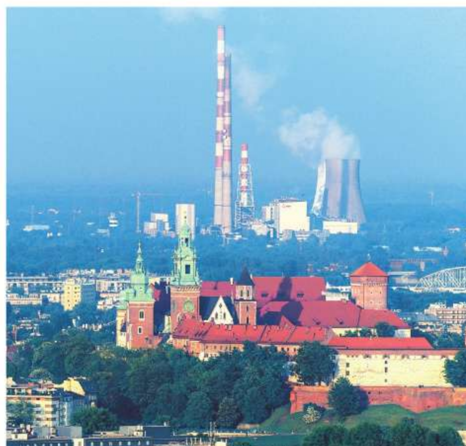
▲ Elektrociepłownie są zwykle zlokalizowane przy rynkach zbytu (na zdjęciu Kraków)
