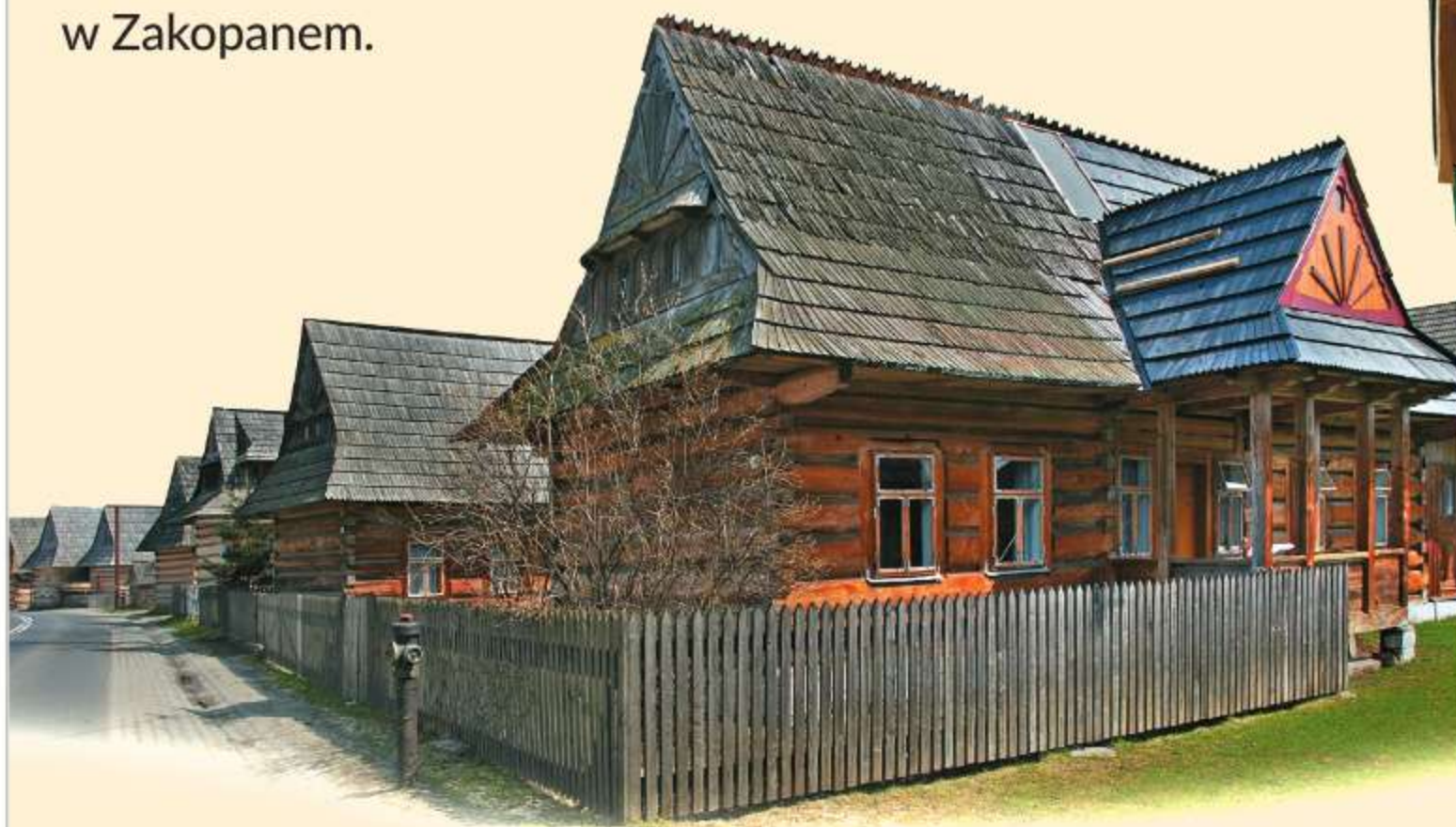
▲ Tradycyjne góralskie chaty w Chochołowie. Strome dachy ułatwiają odpływanie wody i zsuwanie się śniegu
