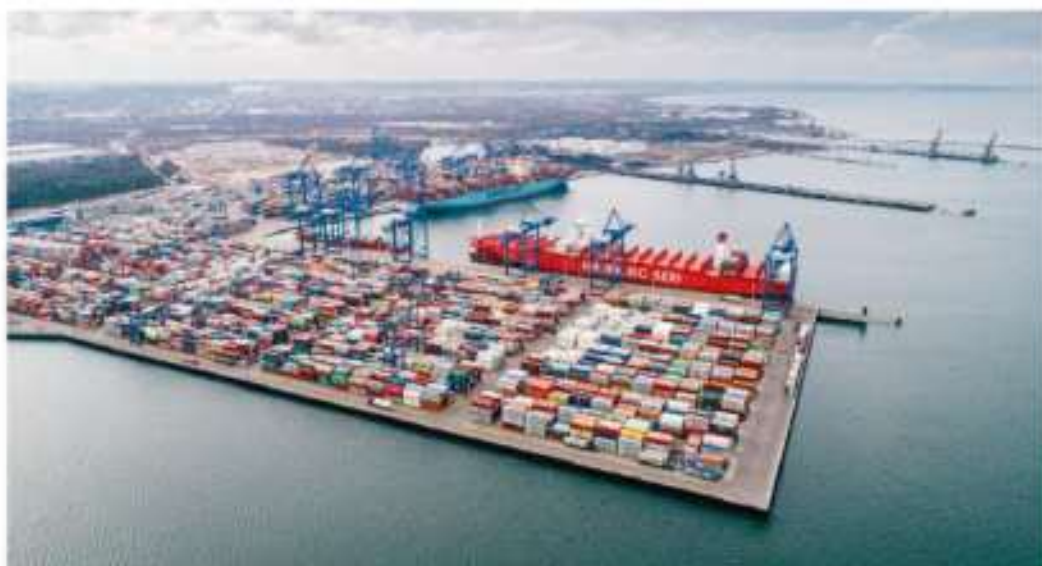
Fot. IV.3.1. Wybudowany w 2007 r. terminal DCT w porcie w Gdańsku znacznie zwiększył możliwości przeładunku kontenerów. Dzięki inwestycji do portu mogą wpływać głębokowodne transoceaniczne kontenerowce, a Gdańsk należy do najważniejszych portów tego typu w Europie.
