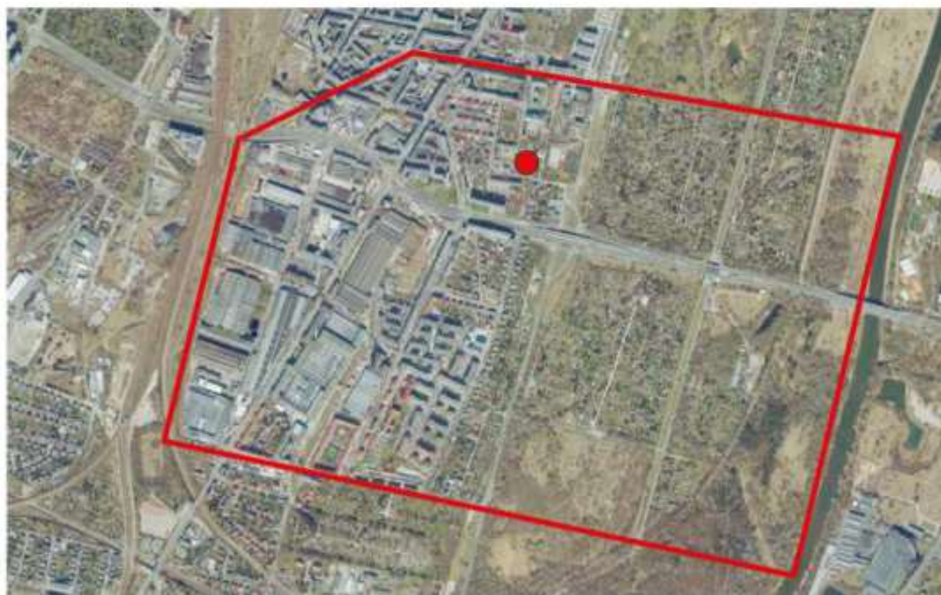
Fot. V.4.2. Obszar badań wyznaczony na Ortofotomapie dostępnej w zasobach Geoportalu. Za granice analizowanego obszaru przyjęto tory kolejowe na zachodzie, rzekę na wschodzie oraz granice kwartałów zabudowy na północy i południu. Czerwonym punktem oznaczono położenie szkoły.
