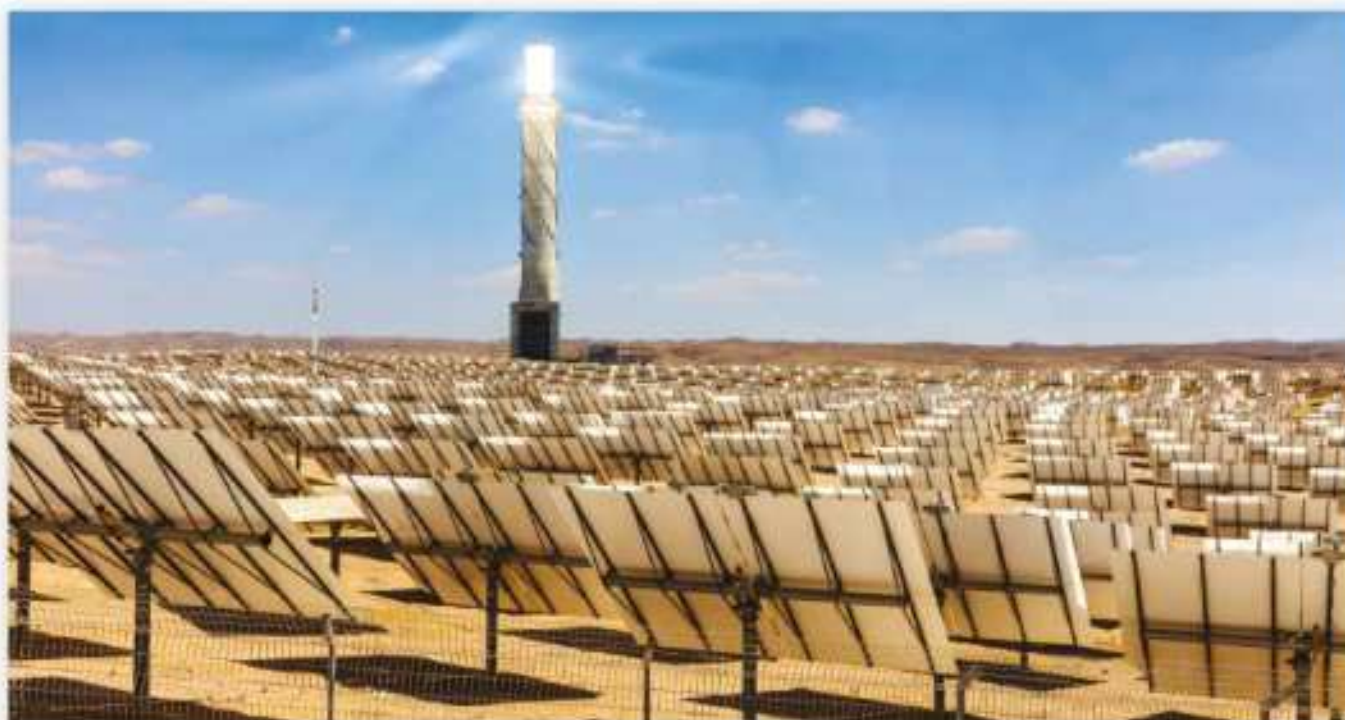
Ryc. V.7.9. Elektrownia słoneczna skoncentrowana (wieża słoneczna) w Izraelu.
