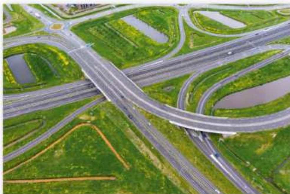
Ryc. VII.6.1. Węzły komunikacyjne powodują degradację i fragmentację krajobrazu. Na zdjęciu Waalwijk w Brabancji w Holandii.
