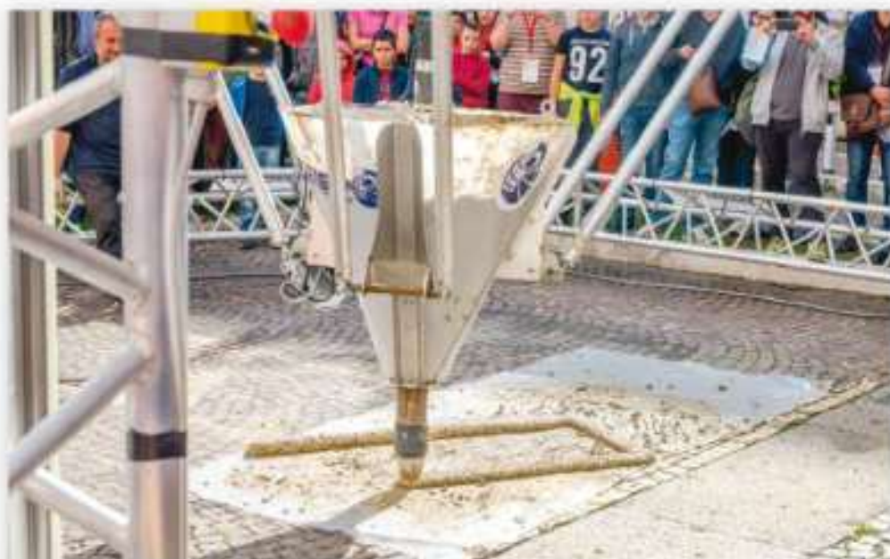
Ryc. III.1.6. Budowa domu za pomocą technologii 3D printing.
