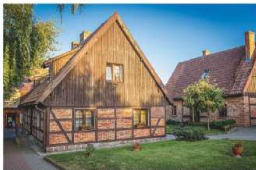
Ryc. V.4.8. Dom zbudowany z wykorzystaniem konstrukcji zwanej murem pruskim.
