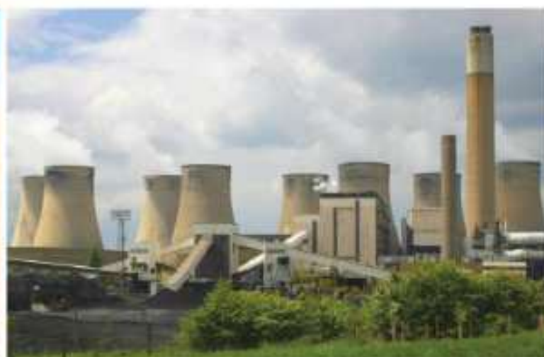
Ryc. V.5.16. Elektrownia ciepła w Nottingham (Wielka Brytania).
