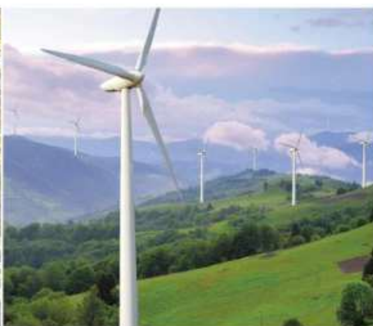
Ryc. V.1.2. Turbiny wiatrowe wytwarzające energię elektryczną.
