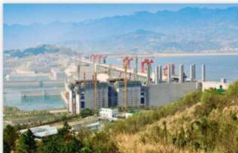
Ryc. 2.5. Jedną z największych budowli hydrotechnicznych na świecie jest Zapora Trzech Przełomów na rzece Jangcy w Chinach. Zbiornik jej towarzyszący ma pojemność ok. 40 km 3 i jest głównie wykorzystywany jako źródło energii i zbiornik przeciwpowodziowy.
