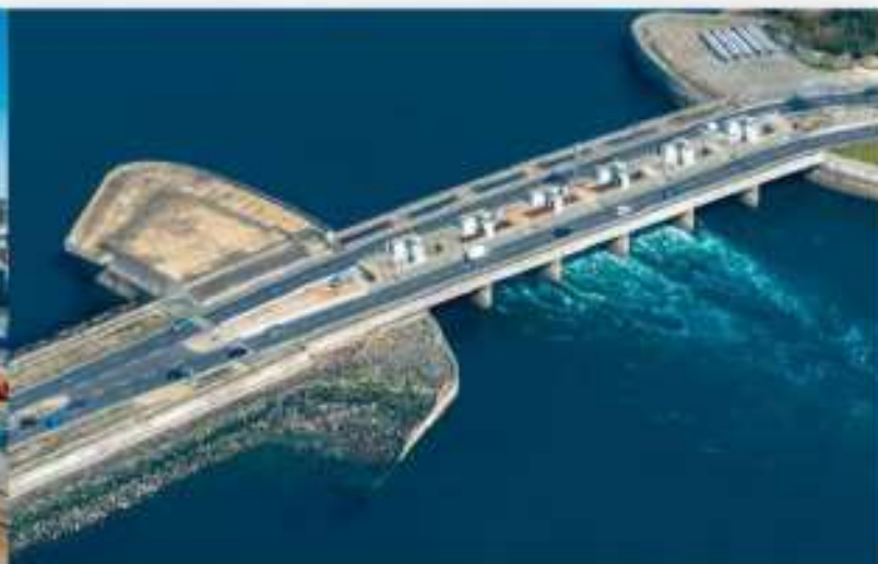
Ryc. 1.11. Elektrownia pływowa Rance (Francja) rocznie produkuje 550 GWh energii, wykorzystując pływy. Służy zamyka się przy najwyższej wartości pływów, a otwiera przy najmniejszej wartości odpływów. Przepływająca woda napędza wtedy turbiny.
