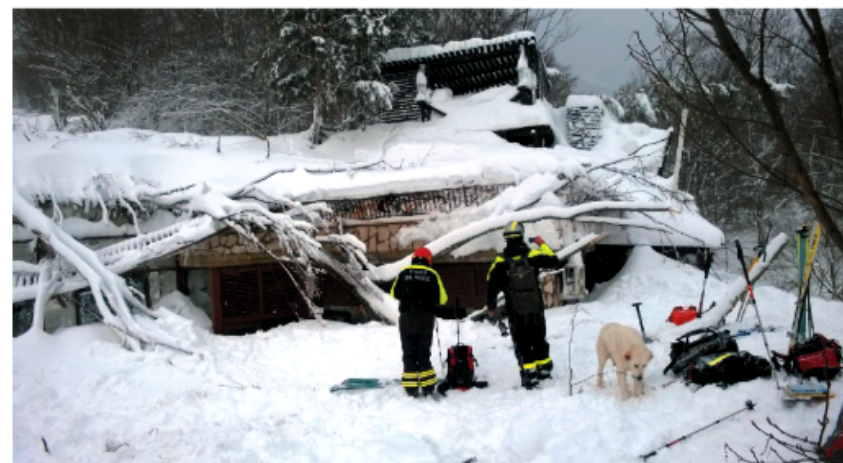
Ryc. 15.1. Zniszczenia spowodowane zejściem lawiny śnieżnej we Włoszech
