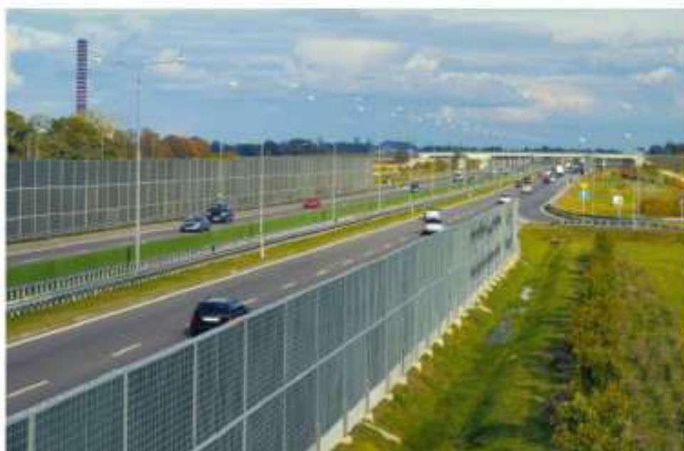
Rys. 14. Drogowe ekrany akustyczne.
