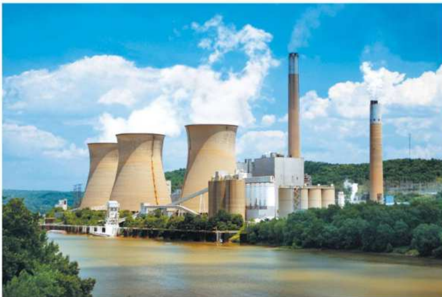
Rys. 6. Zdjęcie elektrowni jądrowej. Wyraźnie widoczne są charakterystyczne wieże chłodnicze, z których wydobywa się para (nie jest to, jak się często błędnie sądzi, wydobywający się dym jak z kominów elektrowni węglowej). Na prawo od wież widać betonowe konstrukcje reaktorów.
