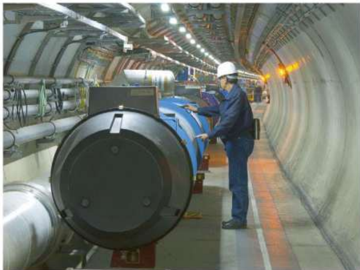
Rys. 12. W Wielkim Zderzaczu Hadronów protony kołują wewnątrz rurki o grubości zaledwie 8 centymetrów. Aby wiązka nie dotknęła ścianki, wymagana jest niesłychana precyzja ułożenia tunelu na długich odcinkach (rzędu 0,1 mm na długości kilku kilometrów).
