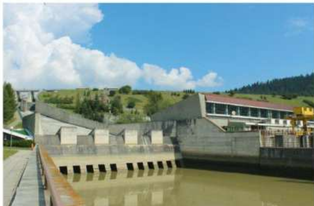
Rys. 8. Szczytowo-pompowa elektrownia wodna na Zbiorniku Czorsztyńskim.
