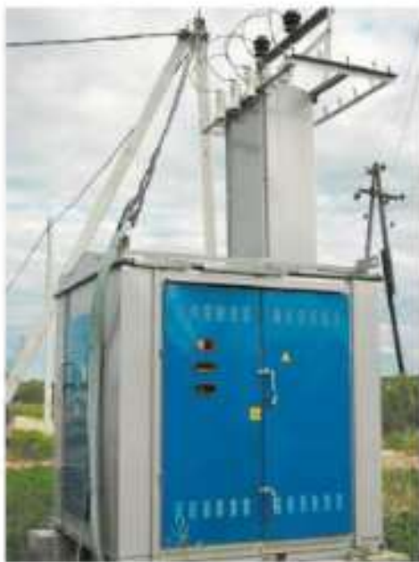
Rys. 3.13. Transformator obniżający napięcie do 230 V.
