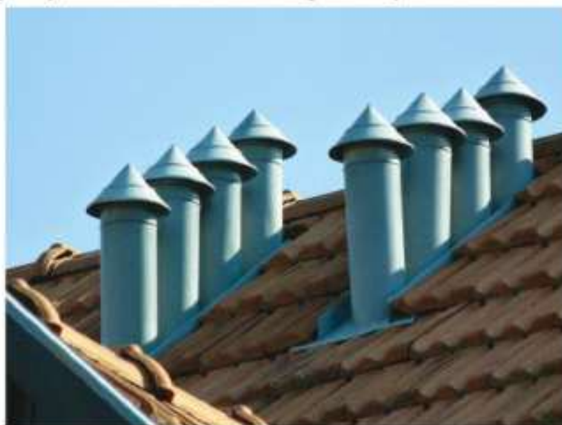
Rys. C.16. Powietrze do kominów wentylacyjnych wpływa przez kratki wentylacyjne, a uchodzi na dachu. Aby powietrze mogło dotrzeć do komina, w drzwiach stosuje się kratki, podcięcia lub otwory wentylacyjne.
