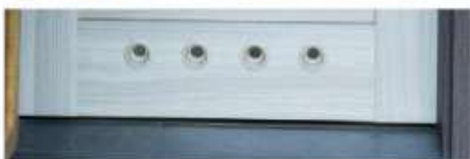
Rys. C.16. Powietrze do kominów wentylacyjnych wpływa przez kratki wentylacyjne, a uchodzi na dachu. Aby powietrze mogło dotrzeć do komina, w drzwiach stosuje się kratki, podcięcia lub otwory wentylacyjne.
