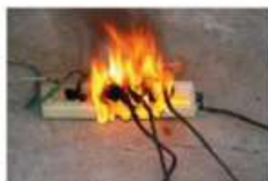
Zwarcia instalacji elektrycznej
