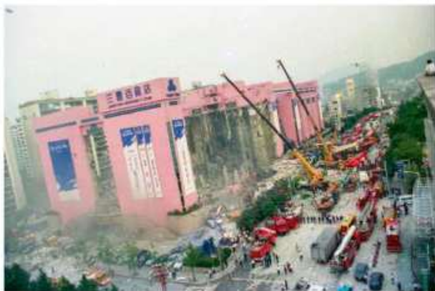
Zawalenie hali handlowej Sampoong w Seulu (Korea Południowa)
