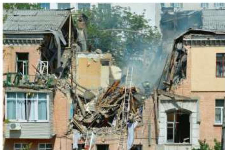
Wybuch butli z gazem w budynku mieszkalnym
