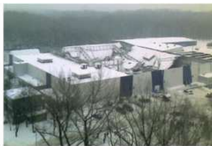
Hala Międzynarodowych Targów Katowickich po zawaleniu się dachu 28.01.2006 r.
