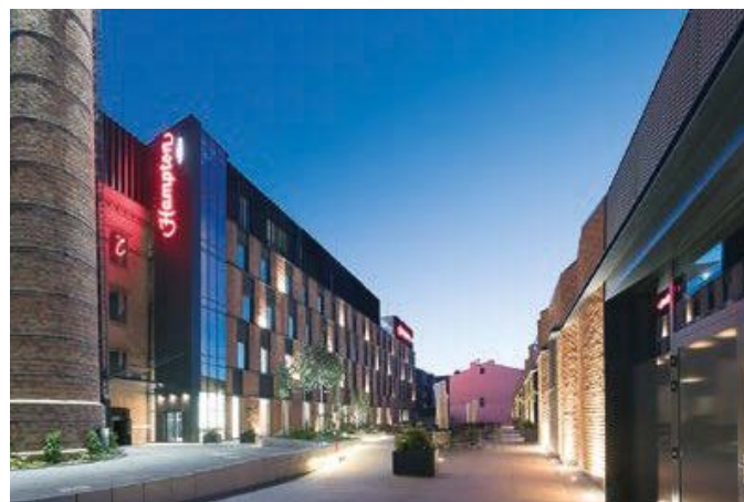
Calisia One to wielofunkcyjny kompleks biznesowy stworzony na terenie dawnej fabryki pianin i fortepianów Calisia w Kaliszu. Oprócz przestrzeni biurowych znajdują się tam kawiarnie i restauracje, a także hotel.
