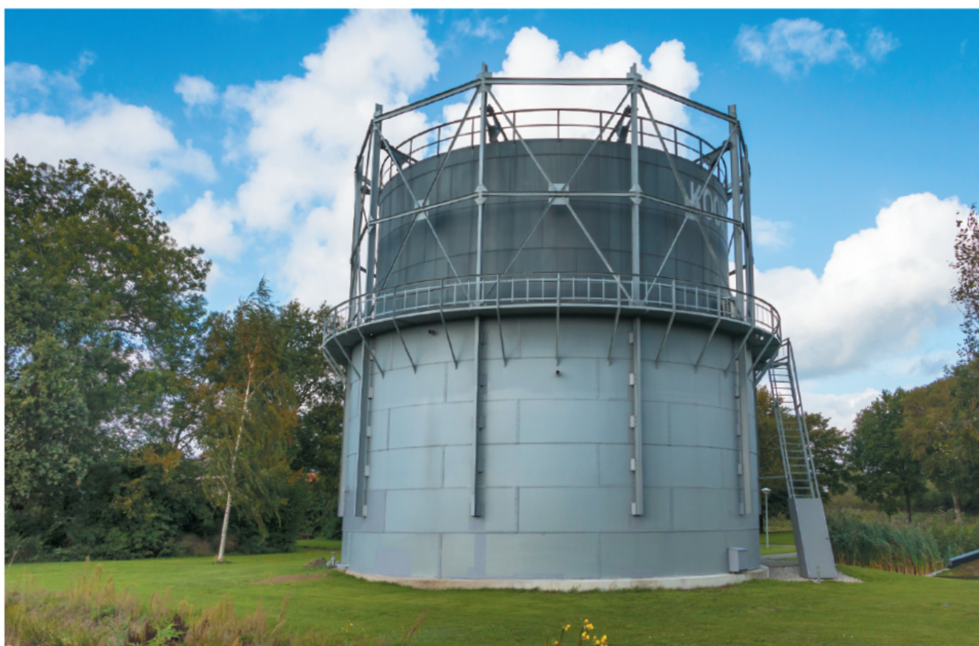
Ryc. 18.2. Zbiornik na gaz składa się z dwóch części, z których górna unosi się lub opada w zależności od ilości gazu w zbiorniku i jego temperatury. Takie rozwiązanie zapewnia stałe ciśnienie gazu w sieci
