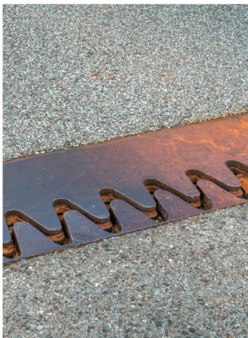
Ryc. 18.3. Szczeliny dylatacyjne na końcu przęsła mostu i łożyska, na których przęsło jest osadzone, zapewniają swobodną zmianę długości związaną ze zmianami temperatury
