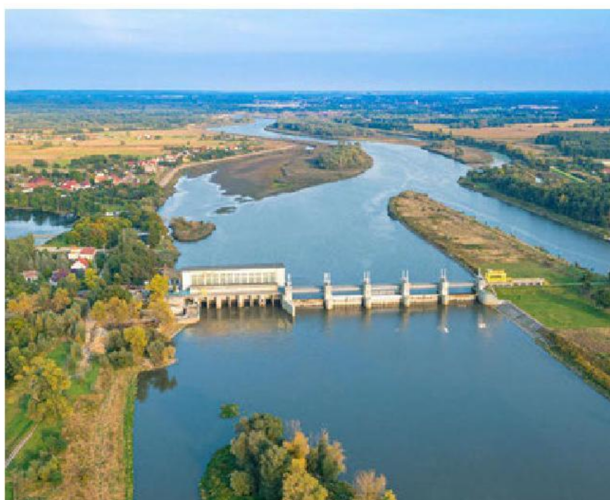
Na uregulowanych odcinkach Odry, np. na wysokości Brzegu Dolnego, powstały stopnie wodne oraz małe elektrownie.
