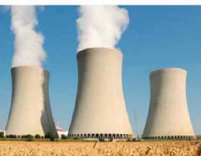
Rys. 8.24. Chłodnie kominowe w elektrowni. Woda paruje w nich i oddaje ciepło
