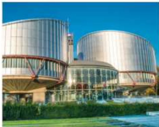
Bryła budynku będącego siedzibą Europejskiego Trybunału Praw Człowieka w Strasburgu przypomina kształtem wagę Temidy – mitycznej bogini sprawiedliwości.
