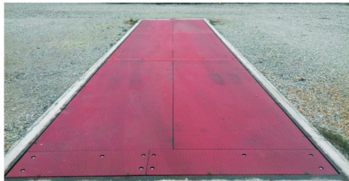
Waga wmontowana w jezdnię
